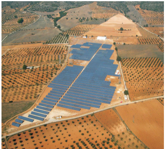
Figuur 1: 'n Voorbeeld van 'n 20 MW FV-sonkragaanleg
